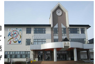
改良工事後の校舎
